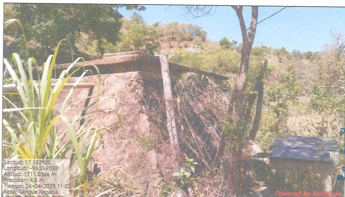
Imagen 11.- Tanque 01, azolvado.
