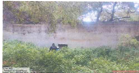
Fot. 8.- Estado actual del vertedor
