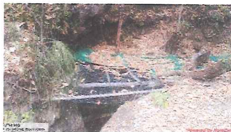
Fot. 2 Estado actual de la captación
