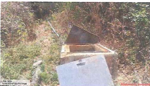
Fot. 3 Estado actual del registro
