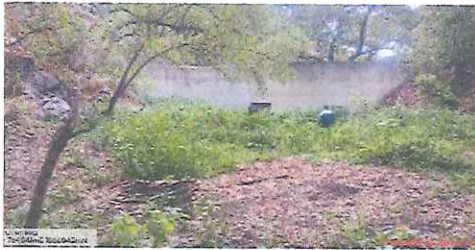
Fot. 7.- Estado actual del vertedor
