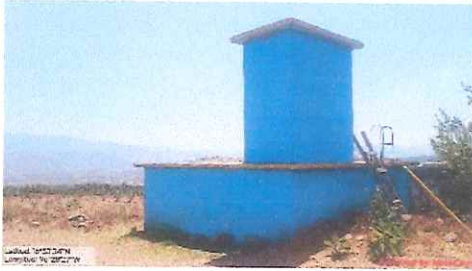
Fot. 5 Ubicación del Tanque 16 de Sep.
