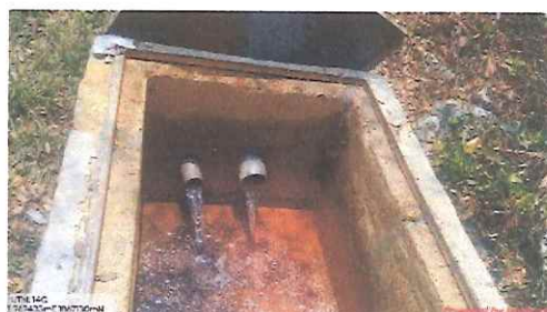
Fot. 4 Estado actual del registro
