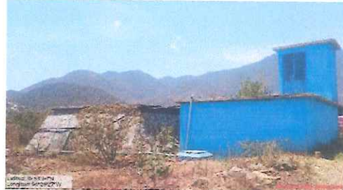
Fot. 6 Ubicación del tanque 16 de Sep.
