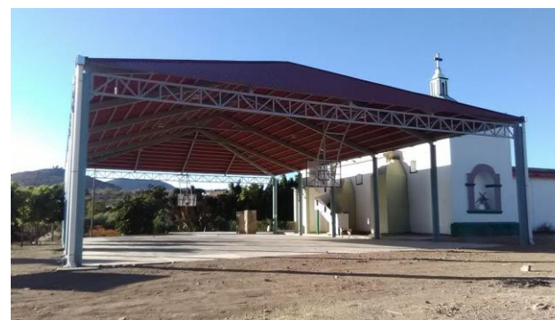
Imagen 21. Cancha de usos múltiples techada de la localidad de Santa Cecilia Jalieza Fuente: Propia autoría.
