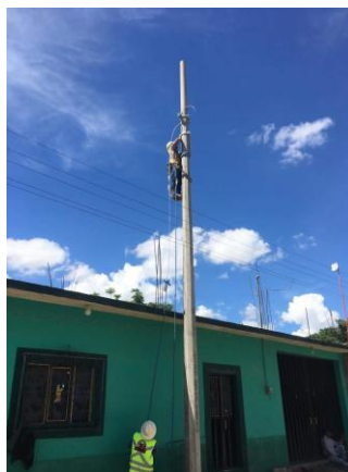
Imagen 31. Red de distribución de energía eléctrica en Santo Tomás Jalieza Fuente: Propia autoría
