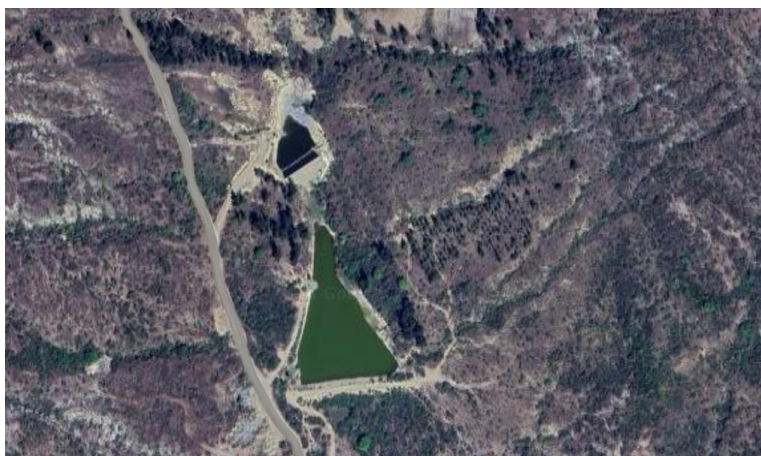
Imagen 26. Presa en territorio de Santo Tomas Jalieza Fuente: https://www.google.com.mx/maps/search/PRESA+D+E+SANTO+TOMAS+JALIEZA/@16.861122,-96.6693507,596m/data=!3m1!1e3?entry=ttu
