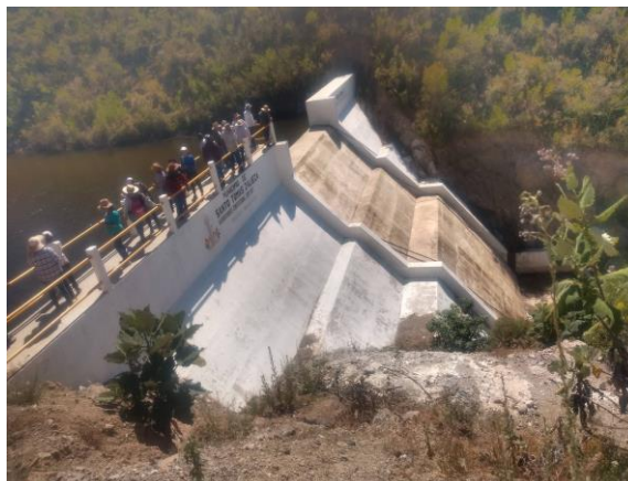
Imagen 47. Colector de agua pluvial localidad de Santo Domingo Jalieza Fuente: Propia autoría.
