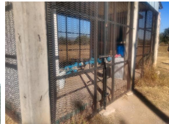
Imagen 44. Pozo de agua profunda en la localidad de Santo Tomás Jalieza. Fuente: Propia autoría.
