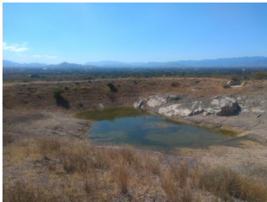
Imagen 45. Olla de captación de agua pluvial. Fuente: Propia autoría.
