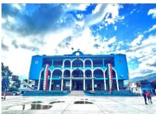
*Diagnóstico Específico:* Es el edificio sede del Ayuntamiento, mantiene un estado físico regular, cuenta con tres niveles y 10 espacios para oficina. Se observan algunos deterioros en su fachada como la falta de pintura, renovación de pisos, impermeabilización en techo, ya que se filtra el agua de la lluvia
