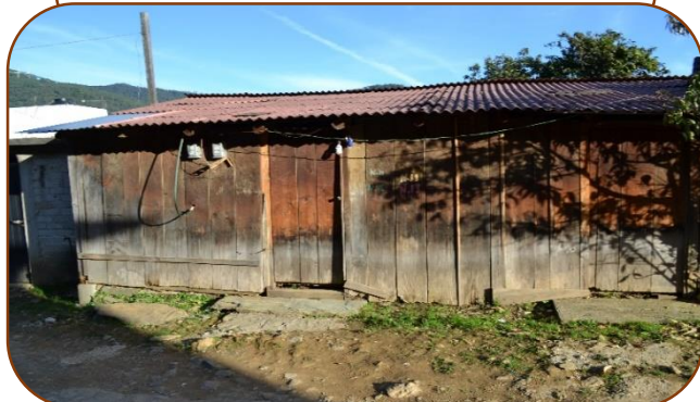
Foto No. 4 Cocina comunitaria de Santa María Pápalo
