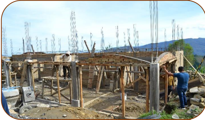
Foto No. 9 Agencia Municipal de Peña Verde (en construcción)
