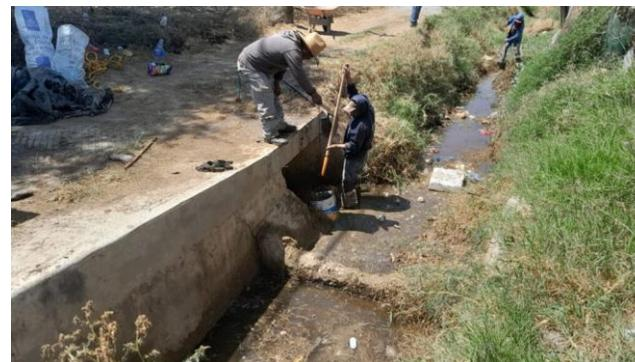
*Fotografía 20. Trabajos de limpieza y desazolve de canales.
