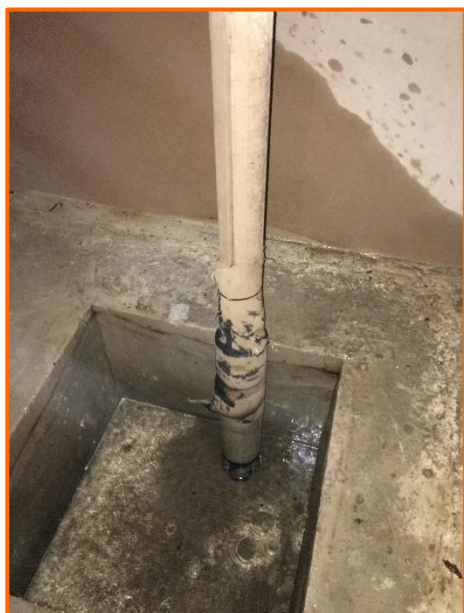
Figura 24. Condiciones deficientes de tuberías de agua potable
