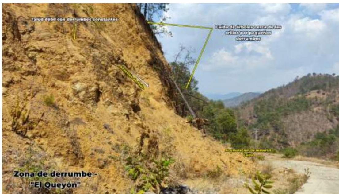
Figura 17. Derrumbes y caída de árboles en el camino que conecta a San Isidro el Queyón con Miahuatlán de Porfirio Díaz
