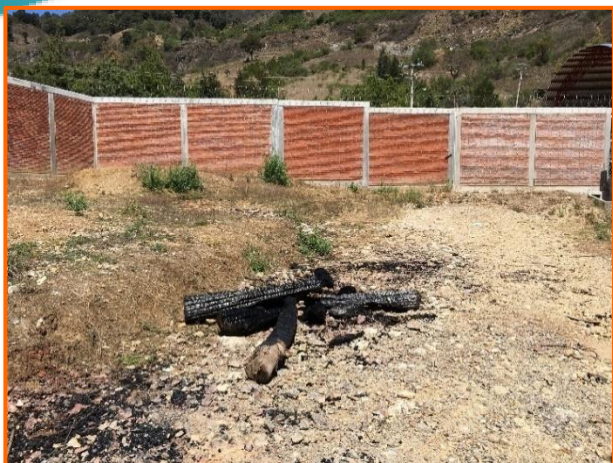
Figura 31. Espacio para la construcción del laboratorio
