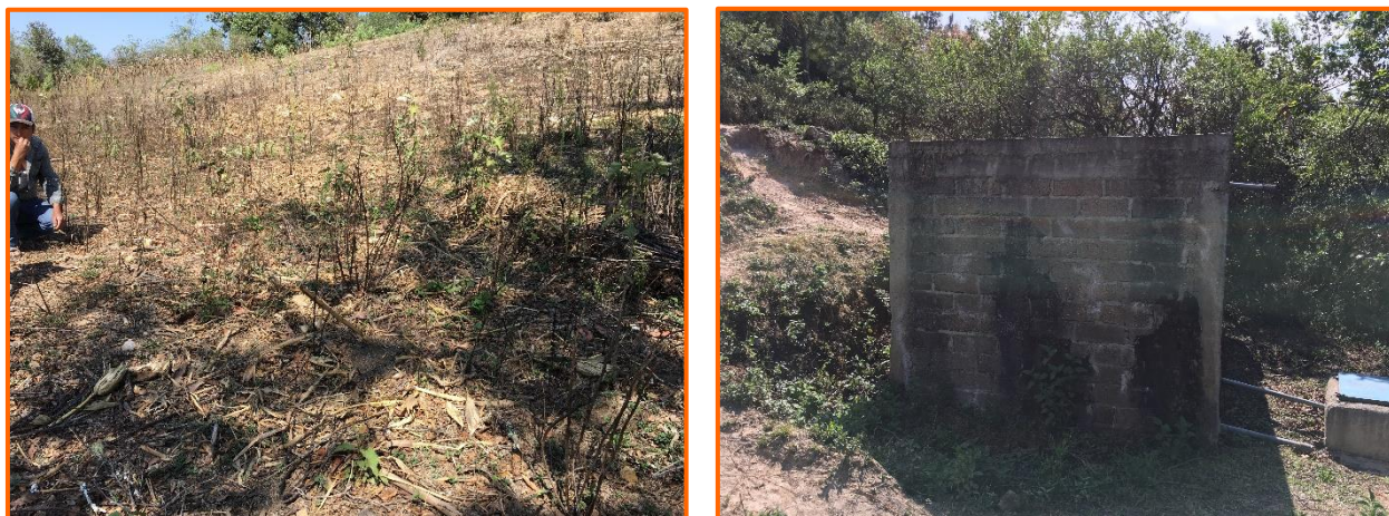
Figura 27. Espacio destinado a la construcción de tanque de almacenamiento para agua entubada
